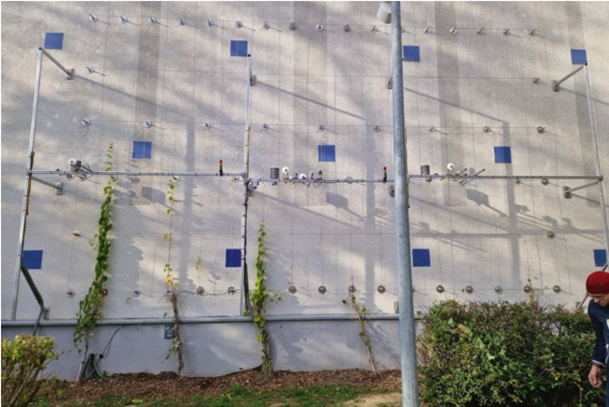
Vorbereitung der VFOS an einer begrünten Fassade
